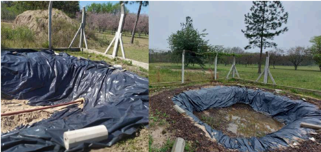
Figura 3. Proceso de construcción del HA.
